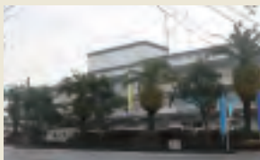
天草市役所。天草市では、同市が有する光ケーブル回線を「あまくさメディカルネット」に提供。高速かつ安全性の高い通信環境の構築・維持を支援している
