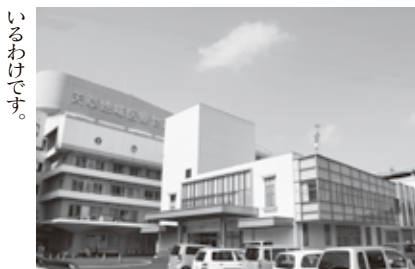
▲昨年増設した新病棟(中央)。右奥上が新設したヘリポート
